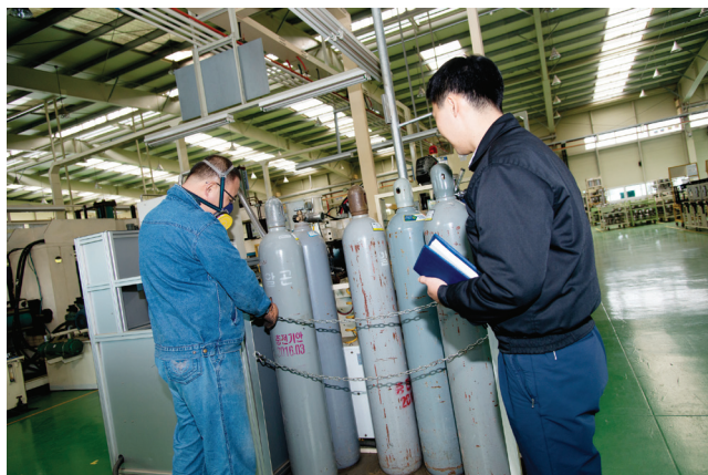
가스 용기 전도 방지를 위해 안전걸이를 설치하는 모습.
